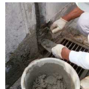
2. モルタルを被せてクニシート C-31も埋め込む。
