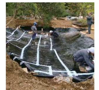
8. クニシートの施工途中。
