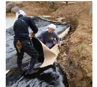
4. 池の上端部は100mm程度淵 からはみ出し貼り付ける。
