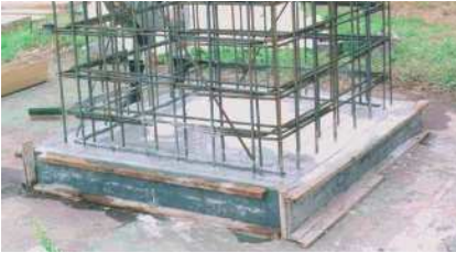
写真1 クニシール設置状況
