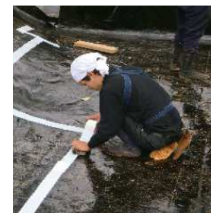
7. クニシートの接合部は、上からクニ シートカバーテープを貼り付ける。
