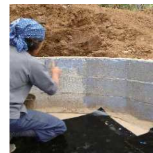
5. 垂直立上り部分に、クニシート ボンドを塗布する。
