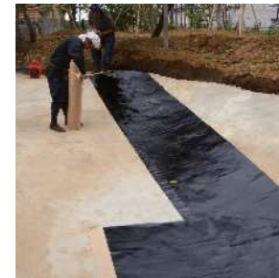
2. クニシートの長辺接合は100mm の重ね貼りをする。
