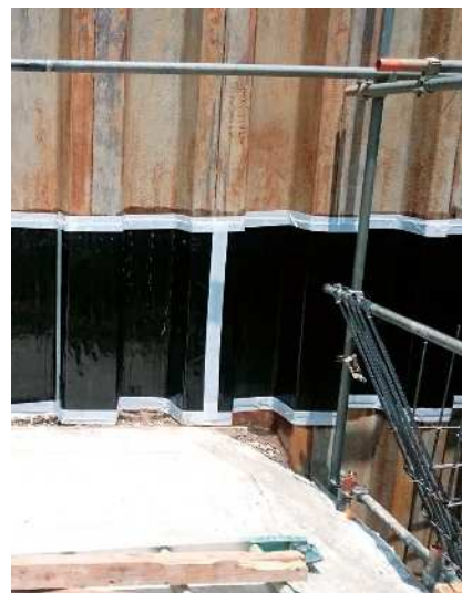
クニシート(シートパイル施工)
