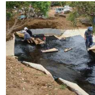
3. クニシートの貼り付け作業は、中央部 の比較的大きなスペースから行なう。
