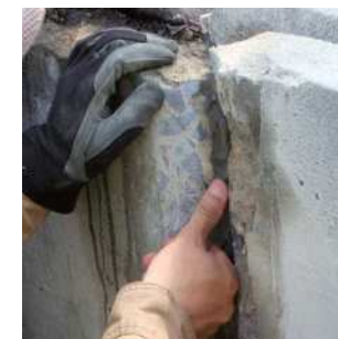
1. Vカットの溝にクニシートC-31 を押し込む。
