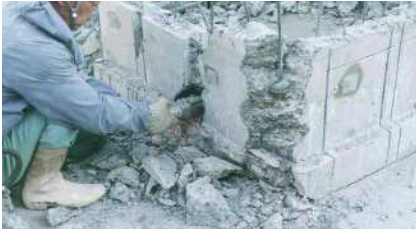
写真2 解体作業状況
