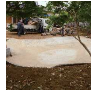
1. 池の予定場所を適当な深さに掘り 先ずは転圧し、ステコンを打設する。
